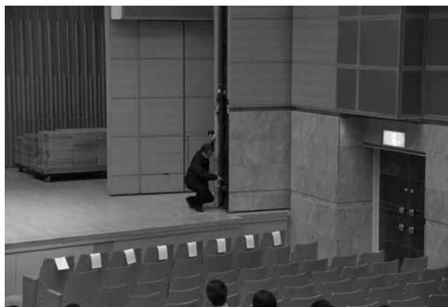
横の反響板（側板）は人力で回転させて固定する。これが袖幕の代わりになる。
